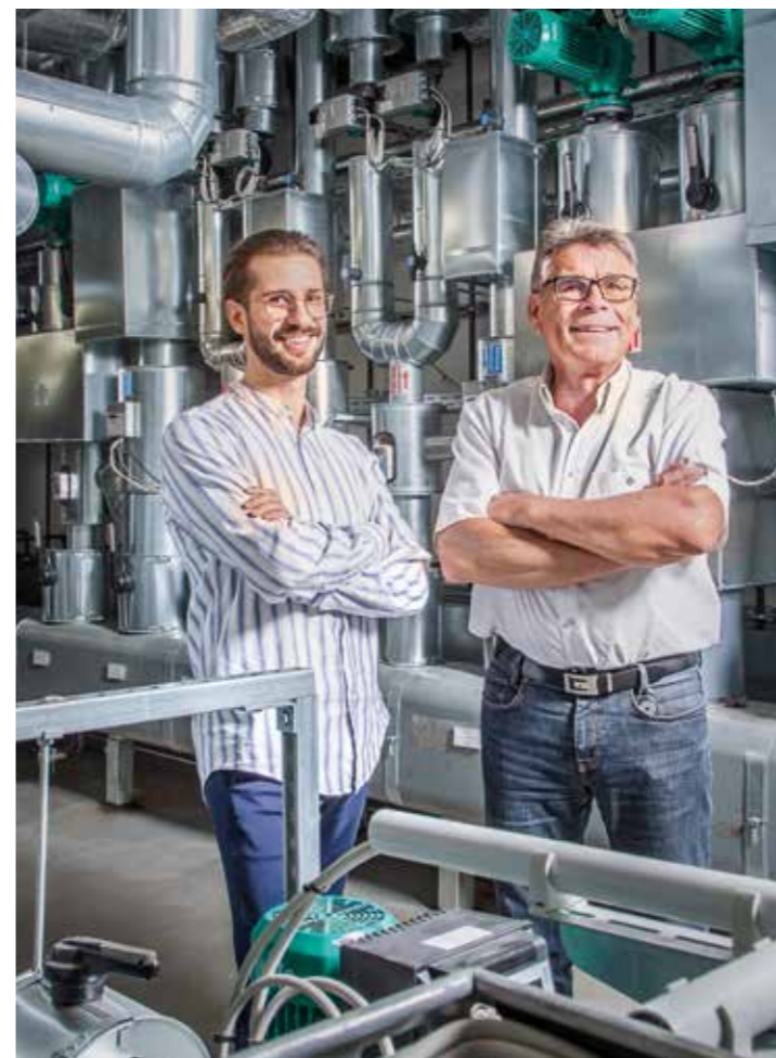
Im Maschinenraum – Hubert Fielenbach (rechts), Leiter Abteilung Haustechnik bei der GBG, und André Karch, Business Development bei der ServiceHaus.
