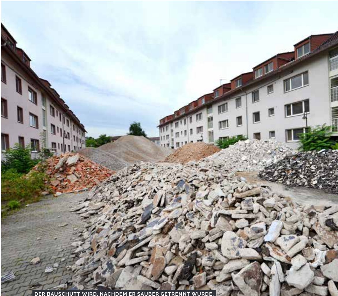
DER BAUSCHUTT WIRD, NACHDEM ER SAUBER GETRENNT WURDE, AUF DER FLÄCHE ALS BAUMATERIAL WEITER VERWENDET.
